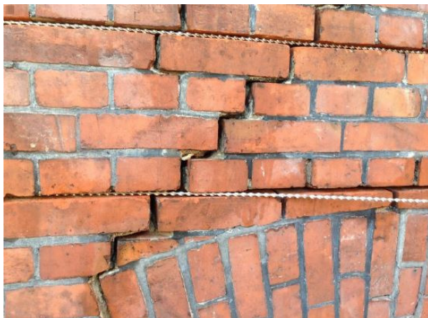
Rys. 1 Przykład montażu prętów systemowych w murze ceglanym
