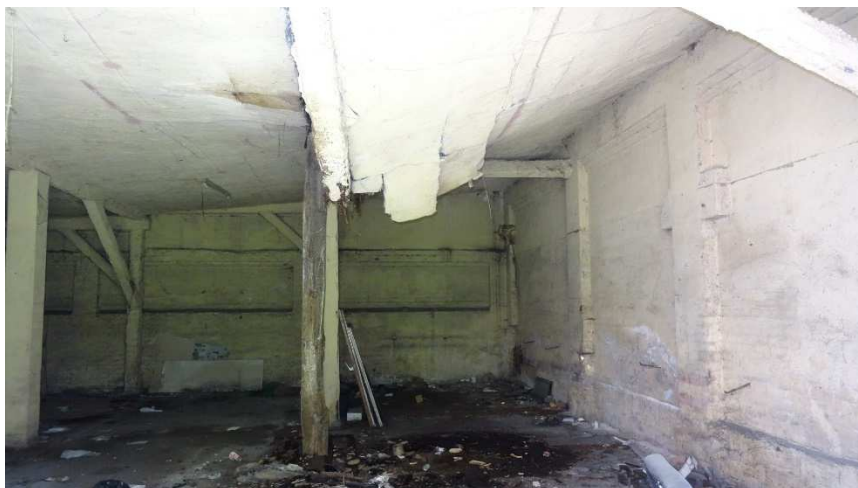
Fot. nr 6 Destrukcja dachu budynku parterowego.
