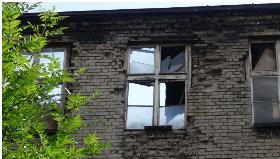
Fot. nr 10 Destrukcja ścian zewnętrznych. Elewacja północna.
