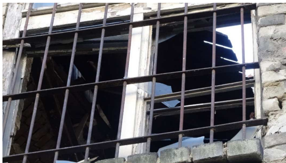
Fot. nr 11 Zawalony dach oraz fragment stropu odcinkowego ceramiczno-stalowego.
