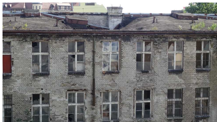
Fot. nr 8 Destrukcja dachu, stropów i ścian zewnętrznych
