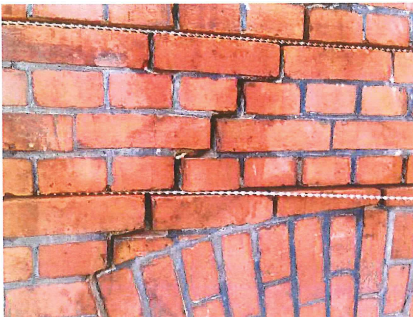
Rys. 1 Przykład montażu prętów systemowych w murze ceglanym
