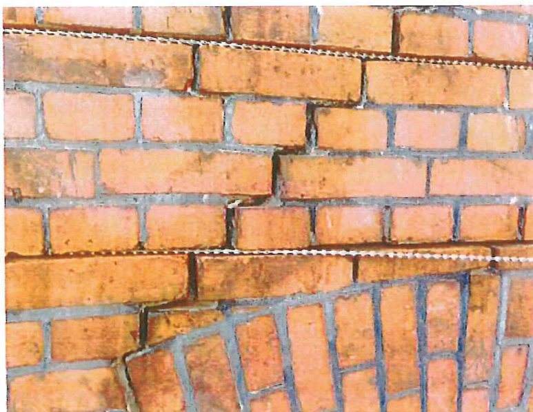
Rys. 1 Przykład montażu prętów systemowych w murze ceglany
