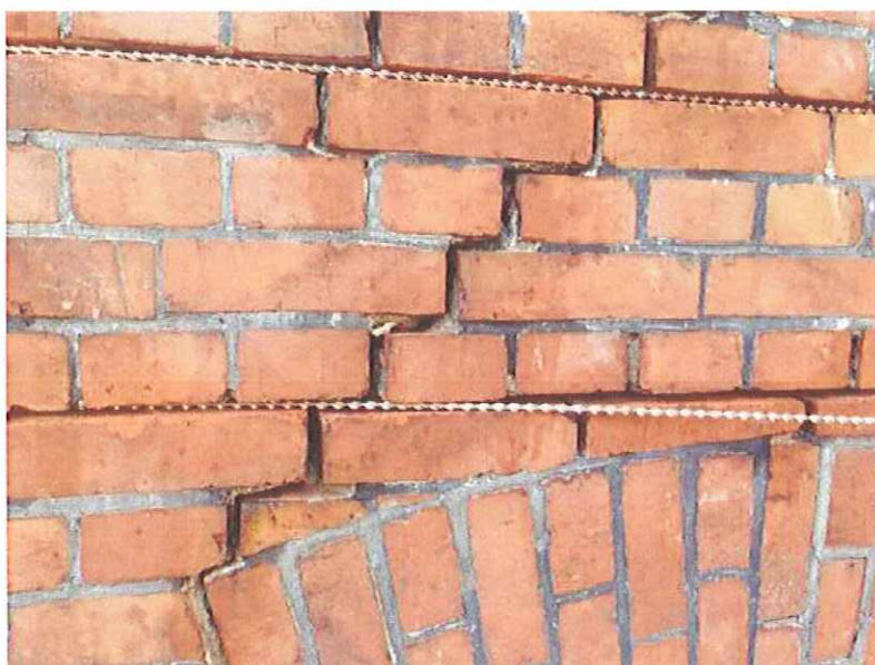
Rys. 1 Przykład montażu prętów systemowych w murze ceglanym
