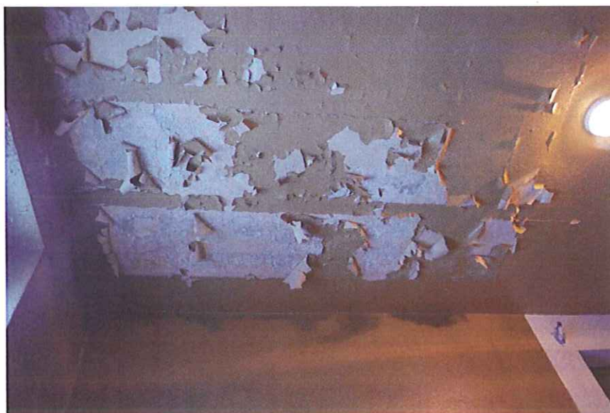
Rys. 3 Widoczne odrapania powłok malarskich
