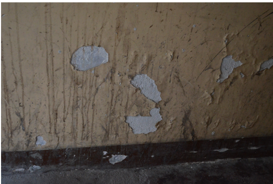
Rys. 3 Widoczne zabrudzenia i odrapania tynku
