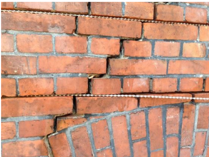
Rys. 1 Przykład montażu prętów systemowych w murze ceglanym
