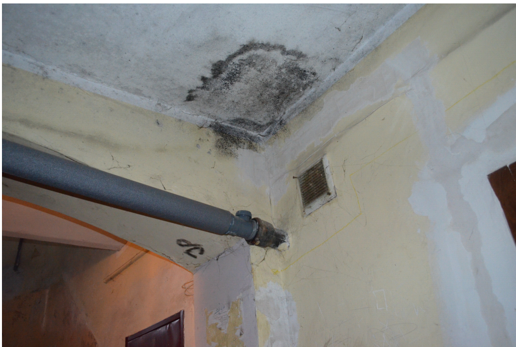
Rys.2 Widoczne zacieki sufitu w strefie wejściowej
