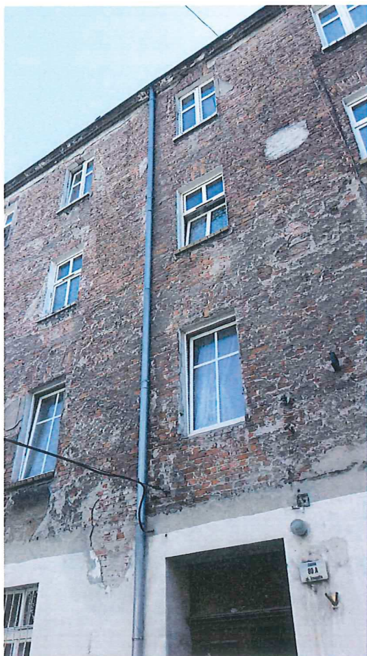
Zdj. 7 wymiana rur spustowych
