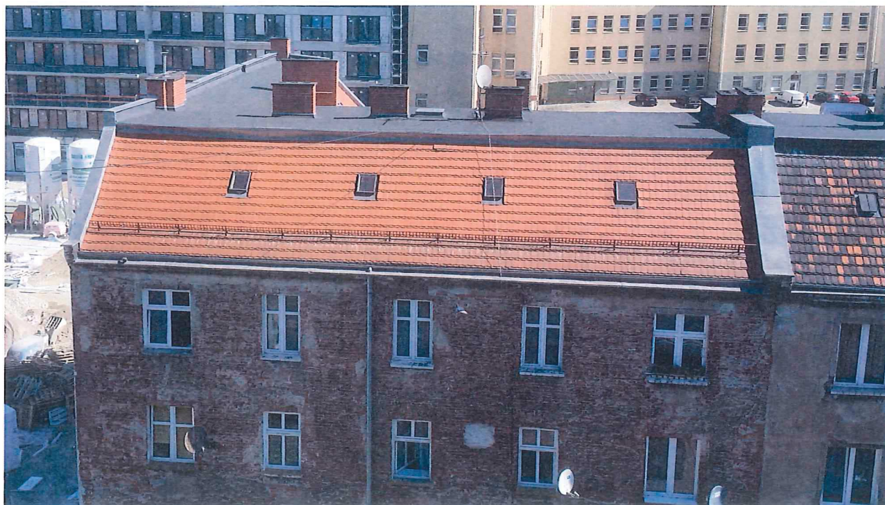
Zdj. 5 Wymienione pokrycie dachu
