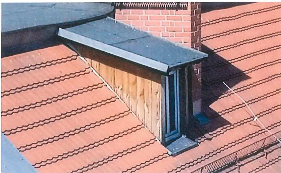
Zdj. 9 Remont lukarny
