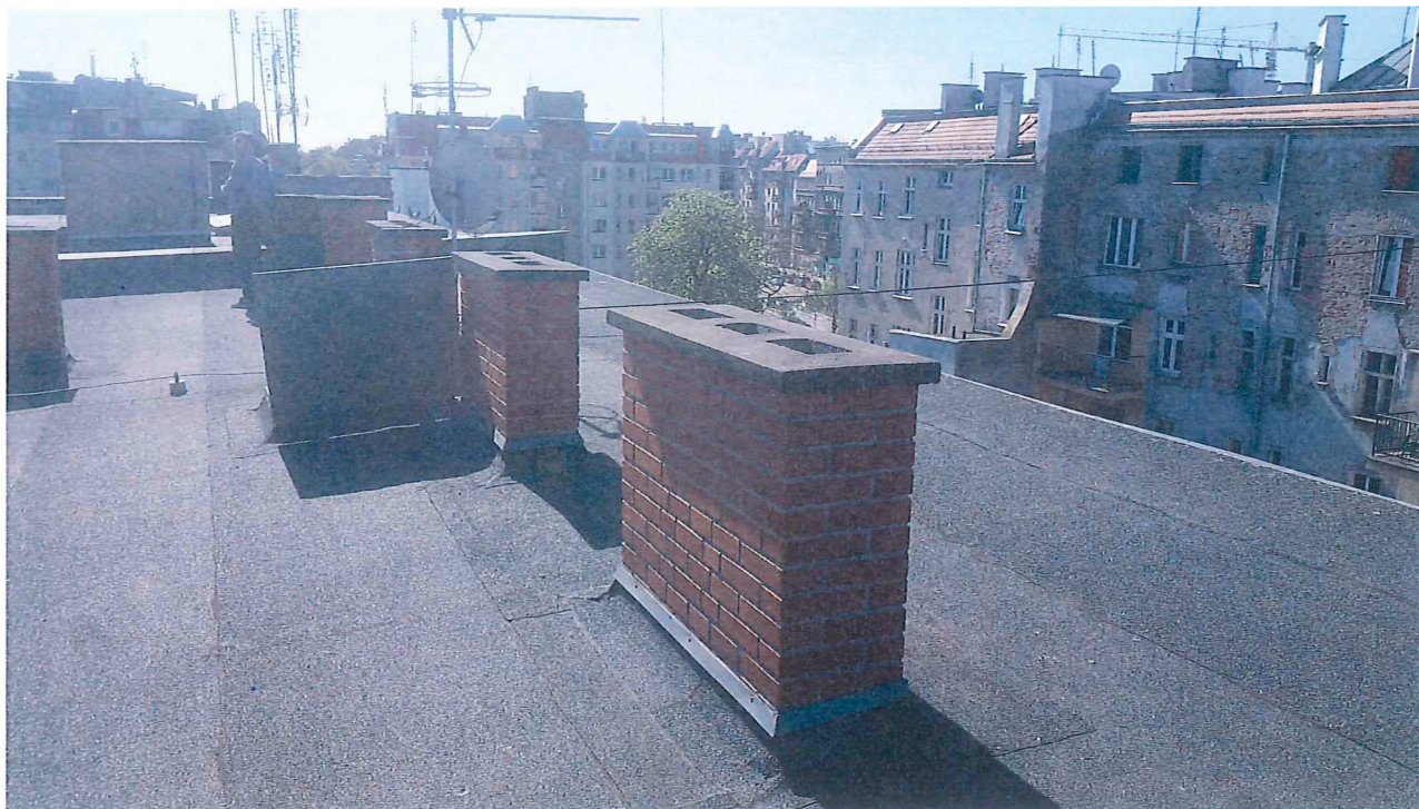
Zdj. 10 Przymurowane kominy
