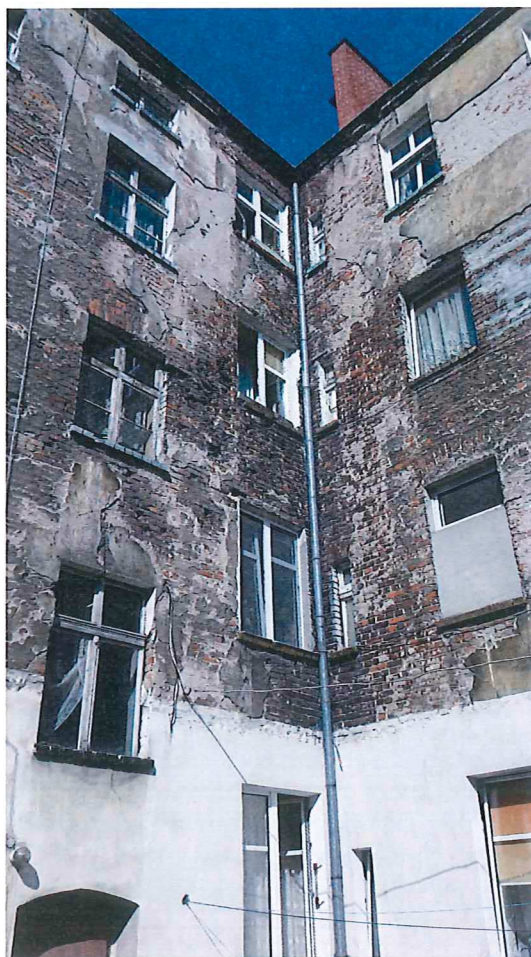
Zdj. 8 Wymiana rur spustowych
