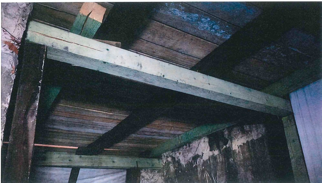
Zdj. 6 Wymienione elementy konstrukcyjne więźby
