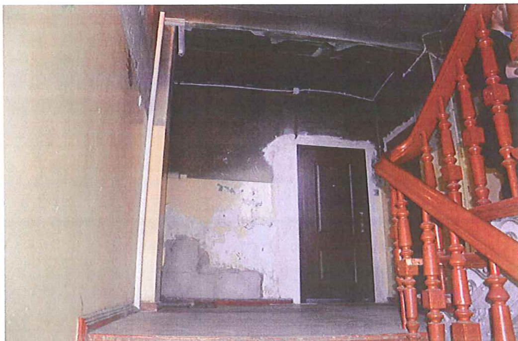
Rys. 4 Widoczne zniszczenia ścian klatki schodowej
