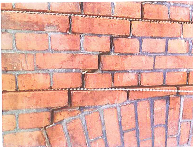
Rys. 1 Przykład montażu prętów systemowych w murze ceglanym
