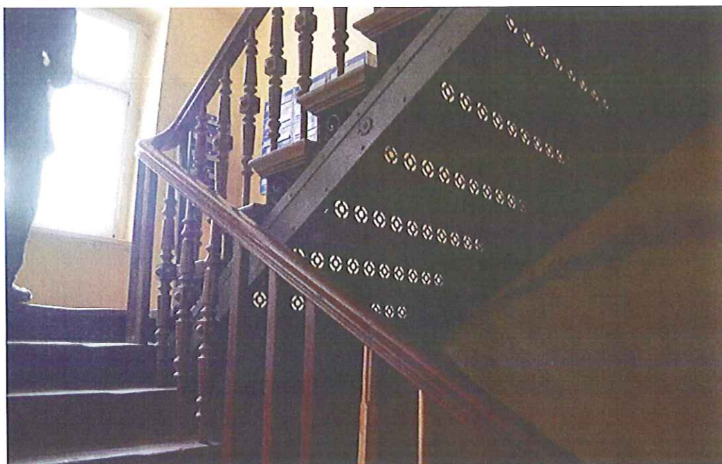
Rys. 5 Tralki do wymiany
