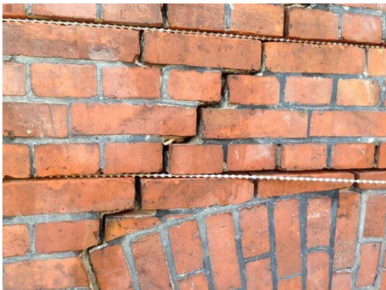
Rys. 1 Przykład montażu prętów systemowych w murze ceglanym
