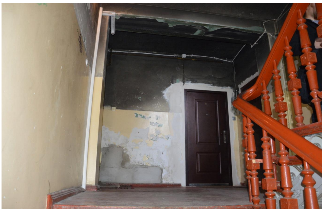
Rys. 4 Widoczne zniszczenia ścian klatki schodowej
