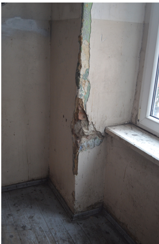
Rys.3 Widoczne odrapania i spękania tynków
