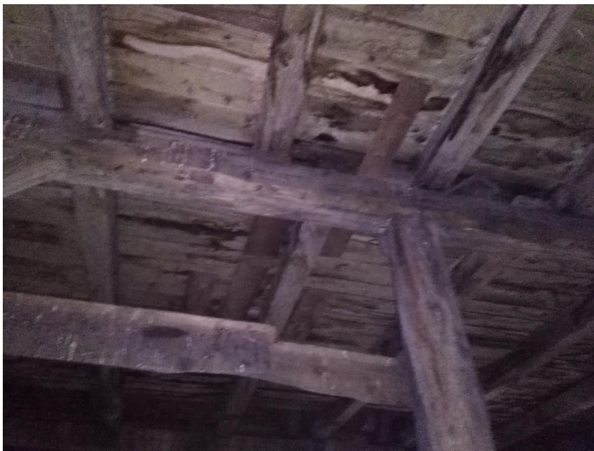
Rys. 5 Widoczne zawilgocenia elementów więźby dachowej
