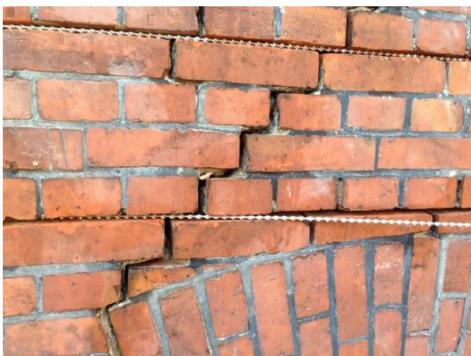
Rys. 1 Przykład montażu prętów systemowych w murze ceglanym
