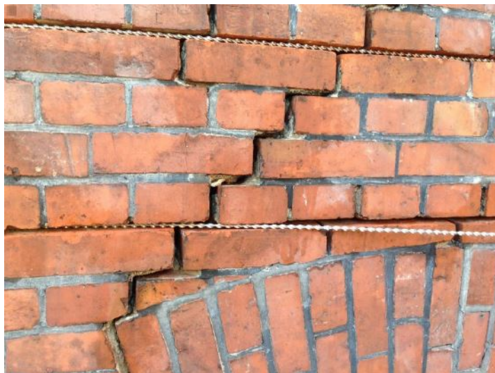
Rys. 1 Przykład montażu prętów systemowych w murze ceglanym
