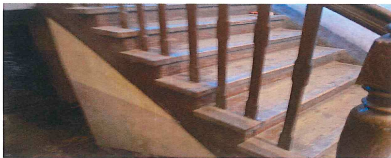
Rys. 2 Widok elementów drewnianych schodów
