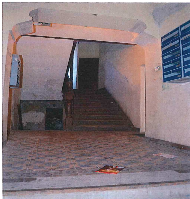
Rys. 3 Widok klatki schodowej od strony wejścia głównego
