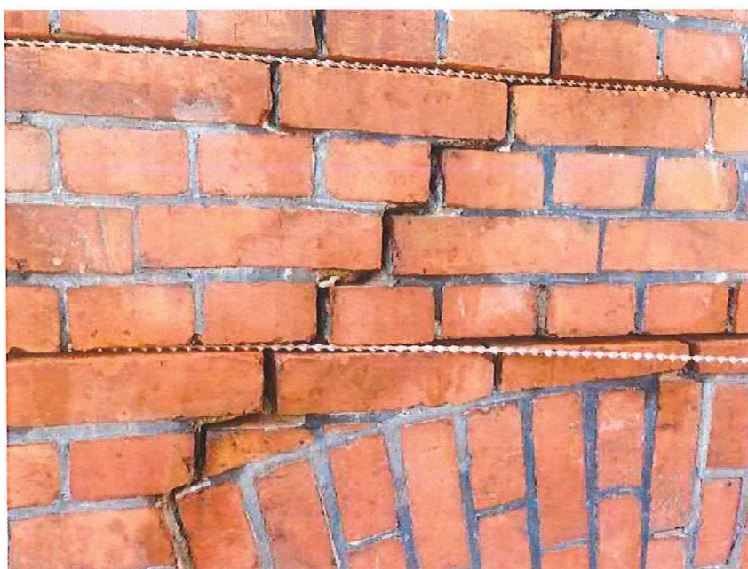
Rys. 1 Przykład montażu prętów systemowych w murze ceglany
