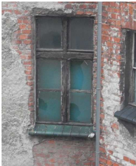
Fot. 8. Istniejące okno na elewacji frontowej jako wzór dla nowej stolarki okiennej.
