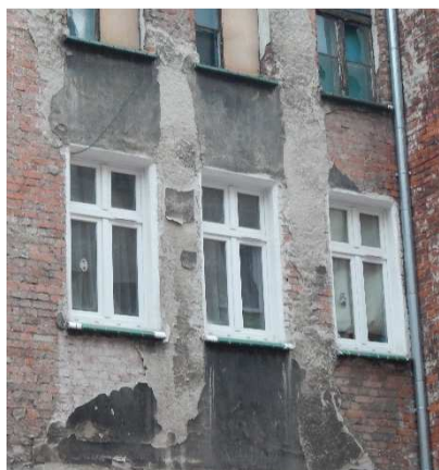
Fot. 5. Fragmenty zachowanego tynku w pasach międzyokiennych.
