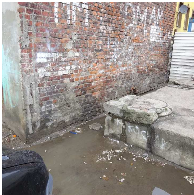
Fot. 4 Widoczny brak opaski od strony elewacji szczytowej.
