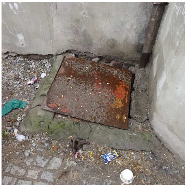
Fot. 3 Studzienka piwniczna z fragmentem opaski od strony elewacji frontowej.
