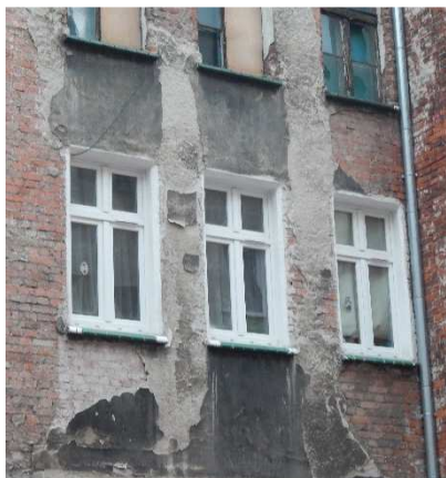
Fot. 6. Fragmenty zachowanego tynku w pasach międzyokiennych
