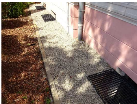
Fot. 5 Przykład wykonania opaski żwirowej wokół studzienek doświetlających piwnice.
