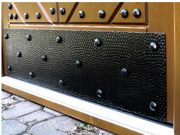
Fot. 7. Przykład zastosowania blachy na drzwiach zewnętrznych.
