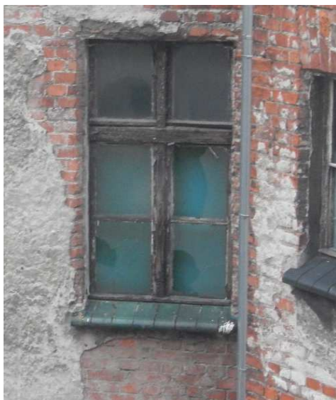
Fot. 11. Istniejące okno na elewacji frontowej jako wzór dla nowej stolarki okiennej.
