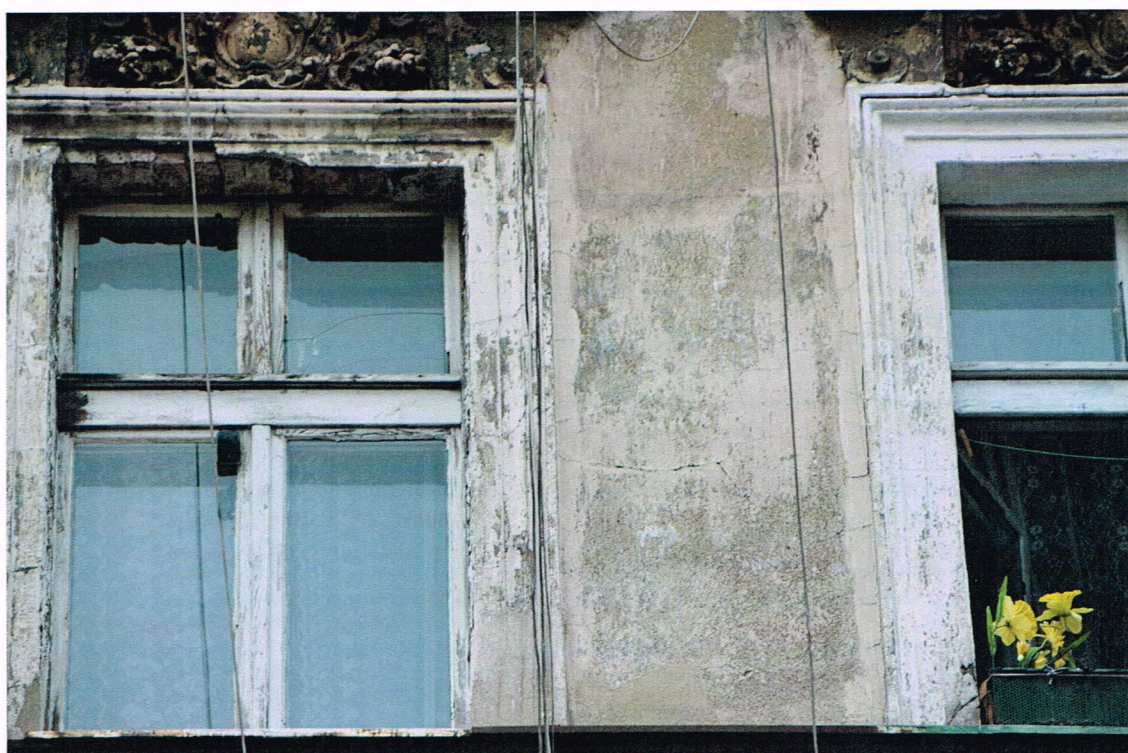
fot. 9: Pas trzeciego piętra. Na odsłoniętym tynku widoczne są pozostałości szarej oraz beżowej malatury.
