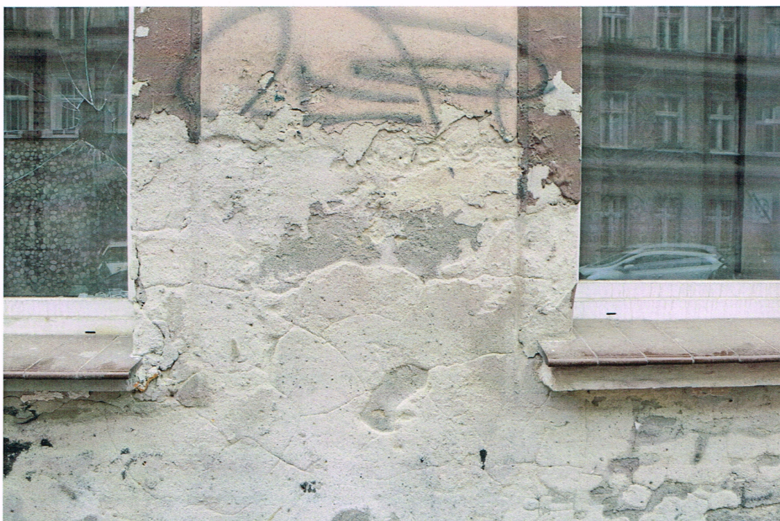
fot. 2: Pas parteru – tynki są znacznie zdegradowane, częściowo wtórnie uzupełnione.
