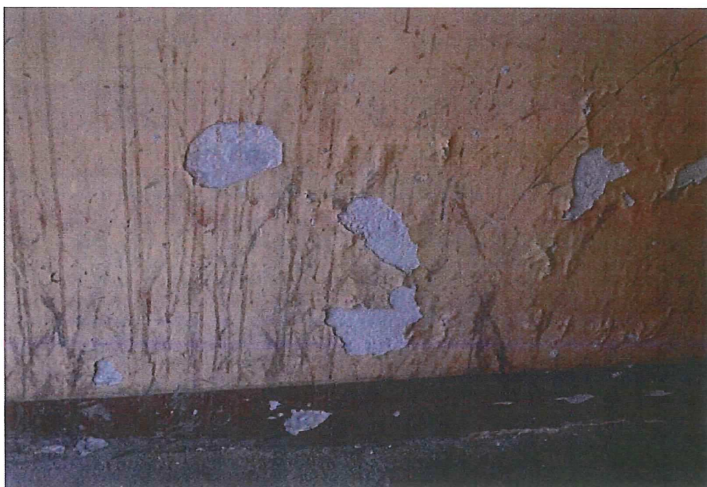
Rys. 3 Widoczne zabrudzenia i odrapania tynku
