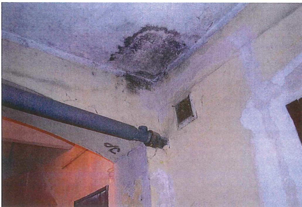
Rys.2 Widoczne zacieki sufitu w strefie wejściowej
