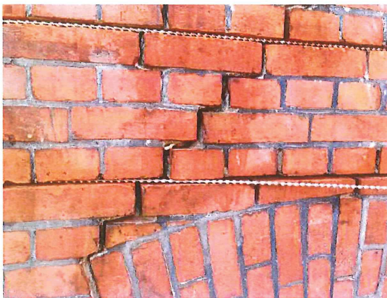
Rys. 1 Przykład montażu prętów systemowych w murze ceglanym
