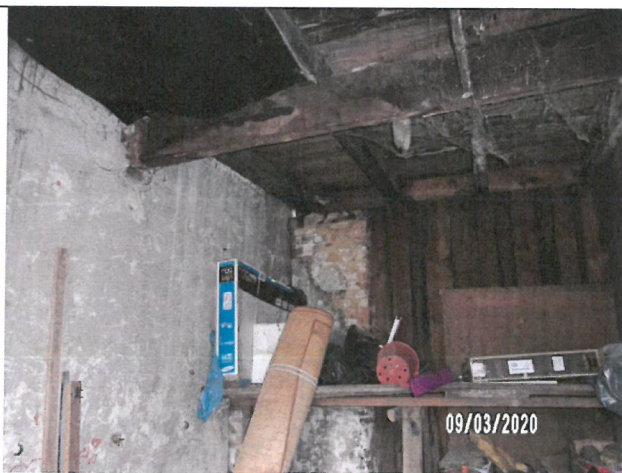
Rys. 9 Widok w garażu nr 1, podparcie belki i słup przy sąsiednim budynku
