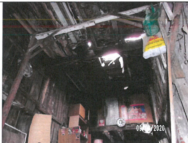
Rys. 6 Stan dachu w garażu nr 2
