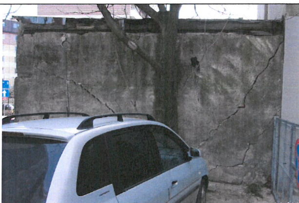
Rys. 3 Widok spękań na ścianie
