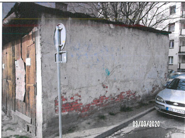
Rys. 5 Zawilgocenia i spękania Północno-Wschodniej ściany
