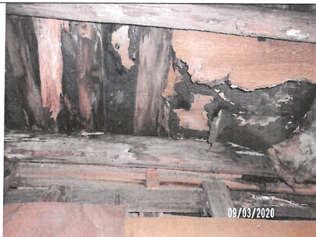
Rys. 8 Widok poszycia dachu w garażu nr 1
