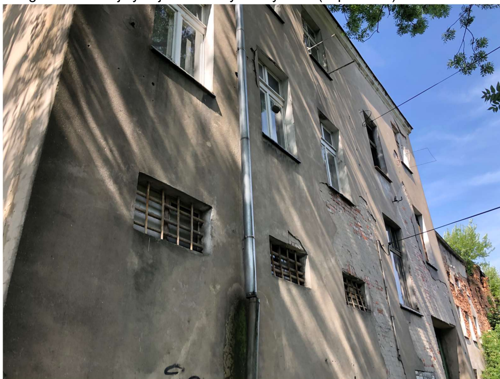
- fragment elewacji tylnej z widocznymi ubytkami ( Opolska 8)
