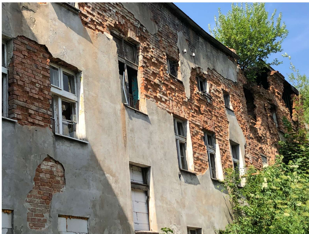
- fragment elewacji tylnej z widocznymi ubytkami ( Opolska 8)
