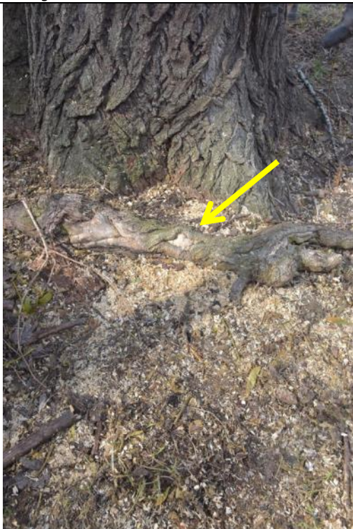
Fot. 6-3, Topola kanadyjska ID 8155, ul. Ciepła 15, Wrocław. Uszkodzenia korzeni położonych na powierzchni gruntu.
