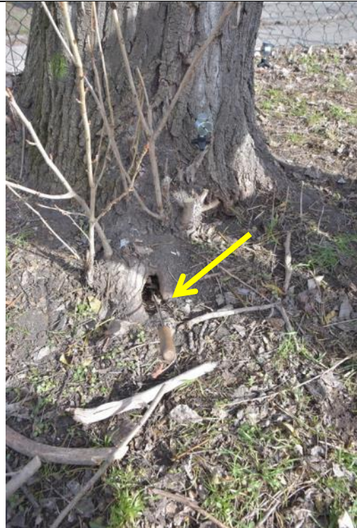
Fot. 4-2. Topola kanadyjska ID 8150, ul. Ciepła 15, Wrocław. U podstawy pnia ubytek – rączka sondy wskazana strzałką.
