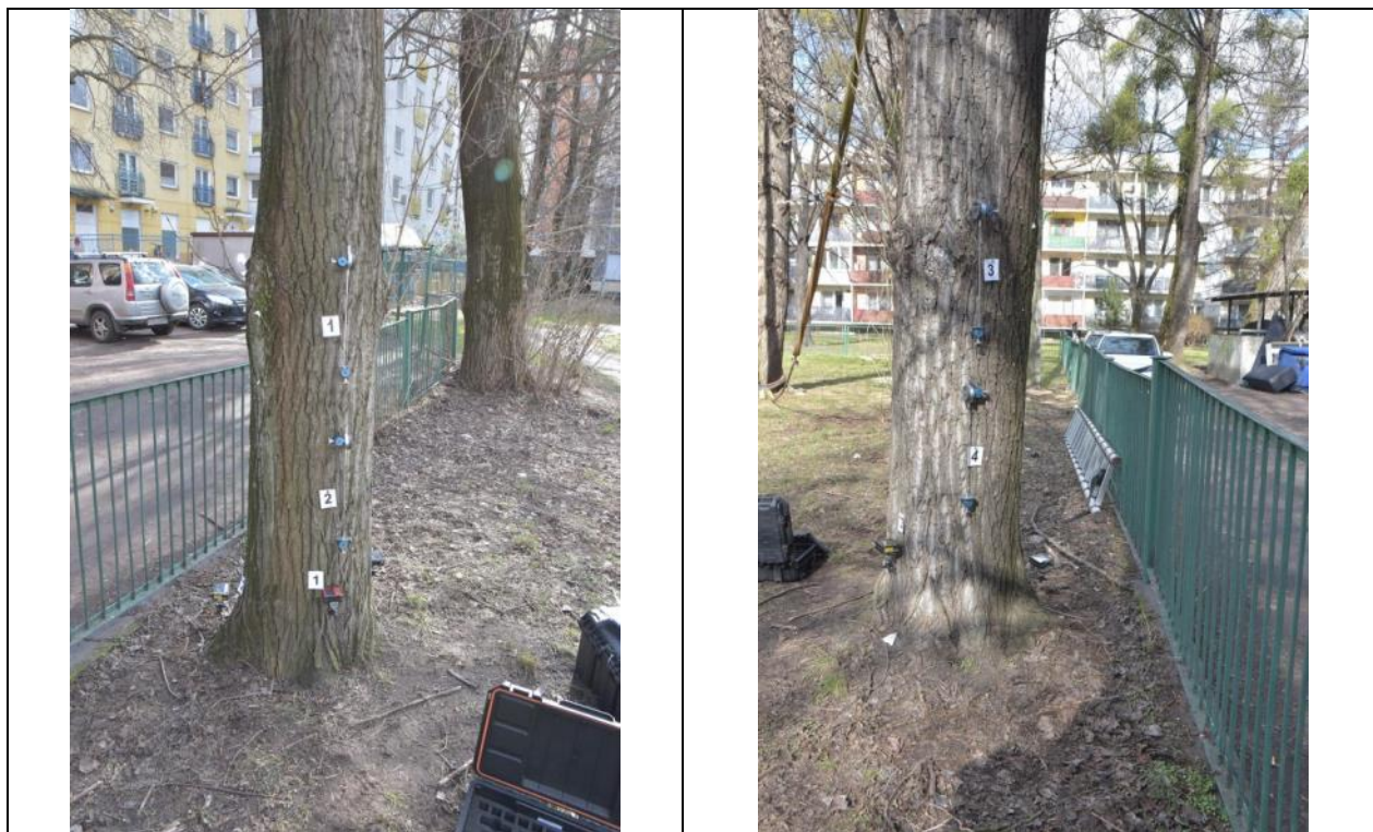
Fot. 8-5. Topola kanadyjska ID 8159 ul. Ciepła 15, Wrocław. Próba obciążeniowa - miejsce mocowania czujników - strona ściskana
