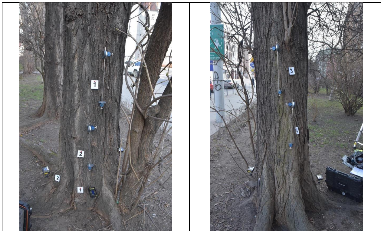
Fot. 2-6. Topola włoska ID 13871, ul. Hubska 41-53, Wrocław. Próba obciążeniowa - miejsce mocowania czujników - strona ściskana
