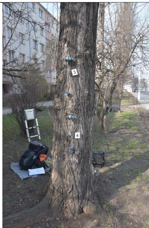
Fot. 3-10. Topola włoska ID 13872, ul. Hubska 41-53, Wrocław. Próba obciążeniowa - miejsce mocowania czujników – strona rozciągana
