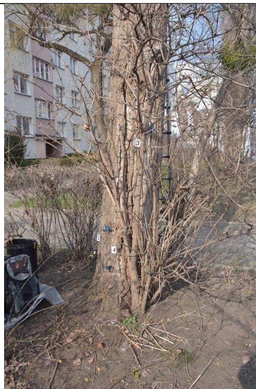
Fot. 4-8. Topola kanadyjska ID 13876, ul. Hubska 41-53, Wrocław. Próba obciążeniowa - miejsce mocowania czujników – strona rozciągana
