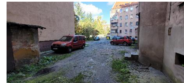
Fot. 12 – Widok część południowo - wschodnia
