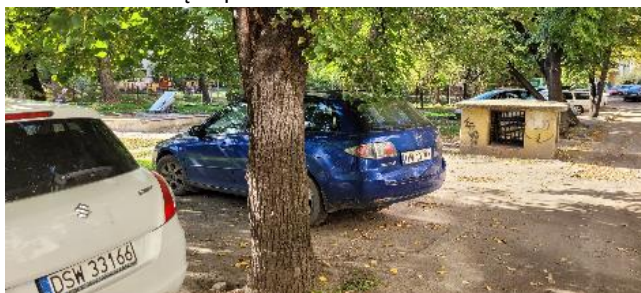
Fot. 48 – Widok część północna – czerpnia w świetle przejazdu
