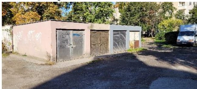
Fot. 17 – Widok garaże
