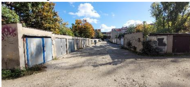
Fot. 22 – Widok garaże
