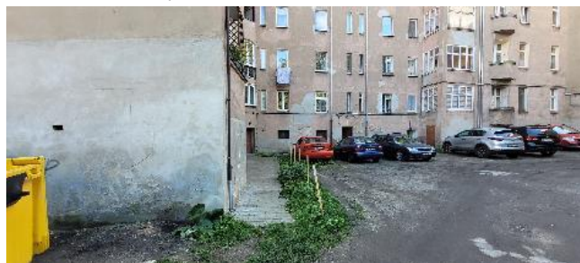
Fot. 8 – Widok część południowo - wschodnia
