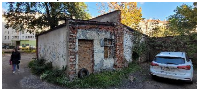
Fot. 28 – Widok część zachodnia – garaż do rozbiórki
