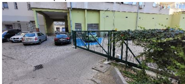
Fot. 36 – Widok część północna - brama od ul. Nowowiejskiej
