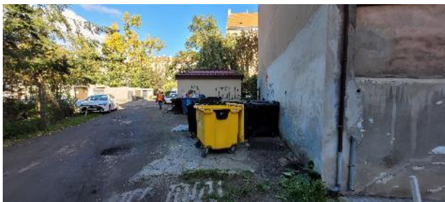
Fot. 9 – Widok część południowo - wschodnia
