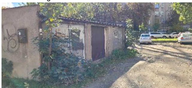
Fot. 20 – Widok garaże
