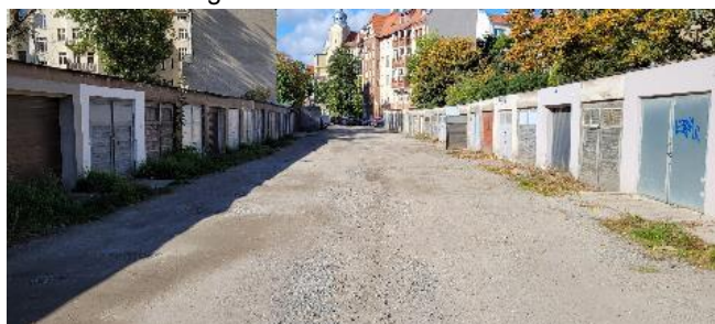
Fot. 19 – Widok garaże
