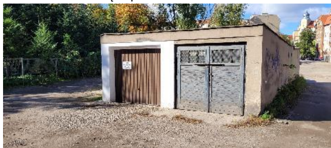
Fot. 15 – Widok garaże
