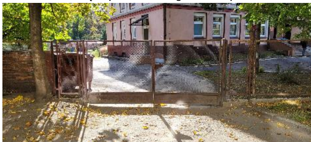
Fot. 42 – Widok część północna – ogrodzenie przedszkola
