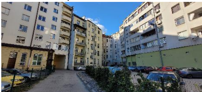
Fot. 33 – Widok część północna
