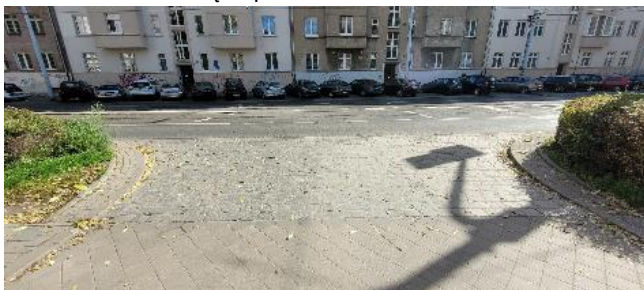
Fot. 53 – Widok część wschodnia – zjazd od ul. Piastowskiej
