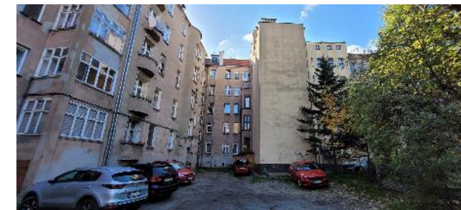
Fot. 10 – Widok część południowo - wschodnia
