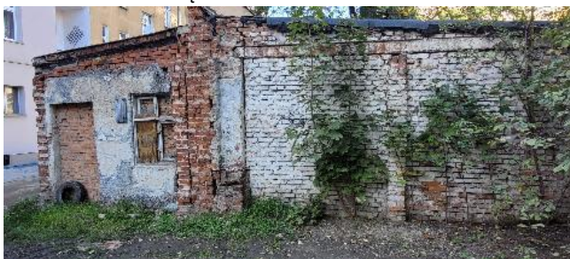
Fot. 27 – Widok część zachodnia – garaż do rozbiórki
