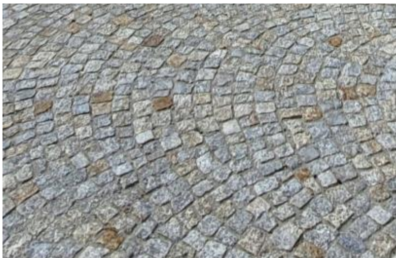
Fot. - Kolorystyka nawierzchni z kostki granitowej o wymiarach 4/6, 7/9 i 9/11 cm (odcień szaro-rudym)
